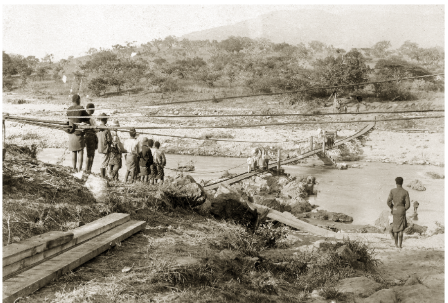
Hulpbrug voor de bouw van de brug over de Elandsrivier (Kaaprivierbrug)
