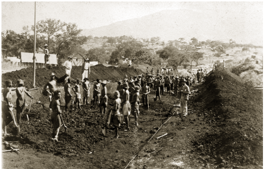
Arbeiders en opzichters bij de aanleg van de Kaaprivierbrug
